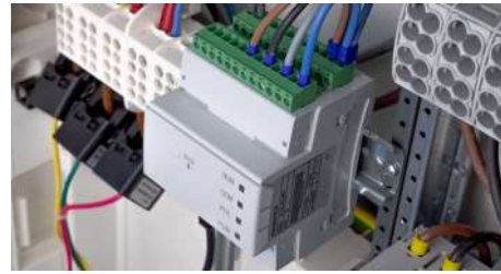
Abb. 42 AWD200 montiert auf Hutschiene (DIN 35 mm)
